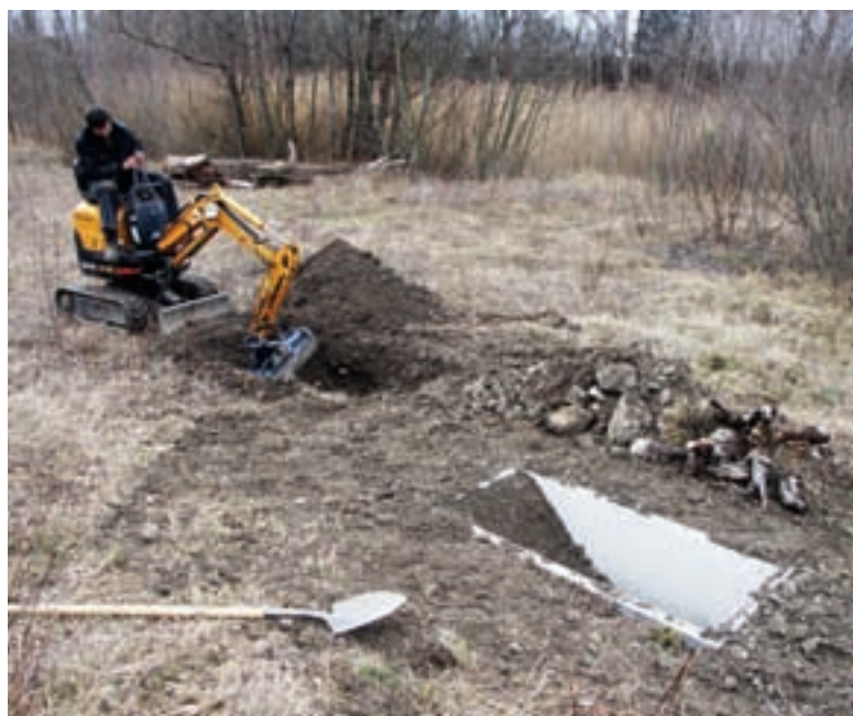
Abb. 6 Einbau der Betongefässe im Geschiebesammler Vaduz (März 2008).
